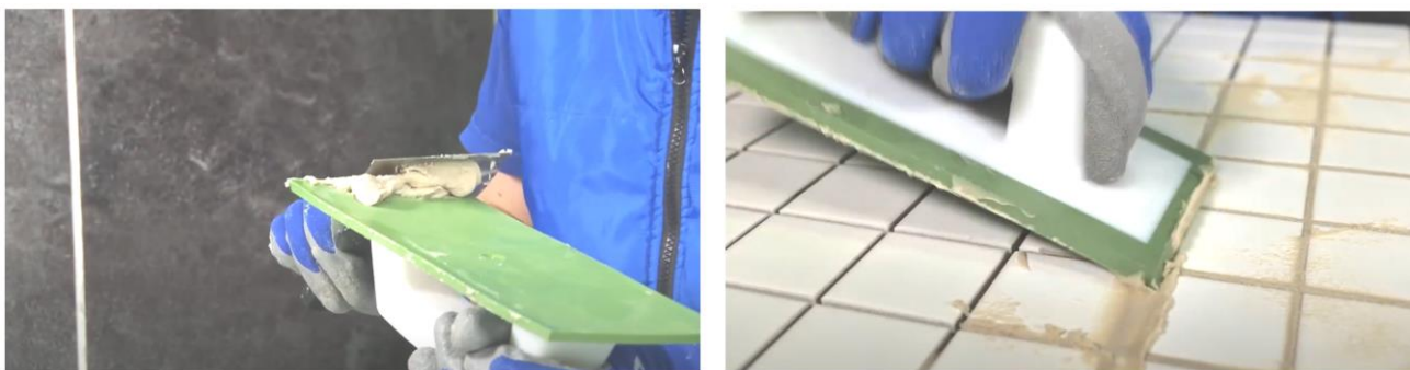
Рис. 43. Заполнение швов затиркой при помощи резинового шпателя
